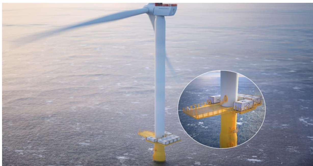
Figur 12. Exempel på vätgasproduktion i nedre delen av tornet i ett havsbaserat vindkraftverk. Källa: Siemens-Gamesa
