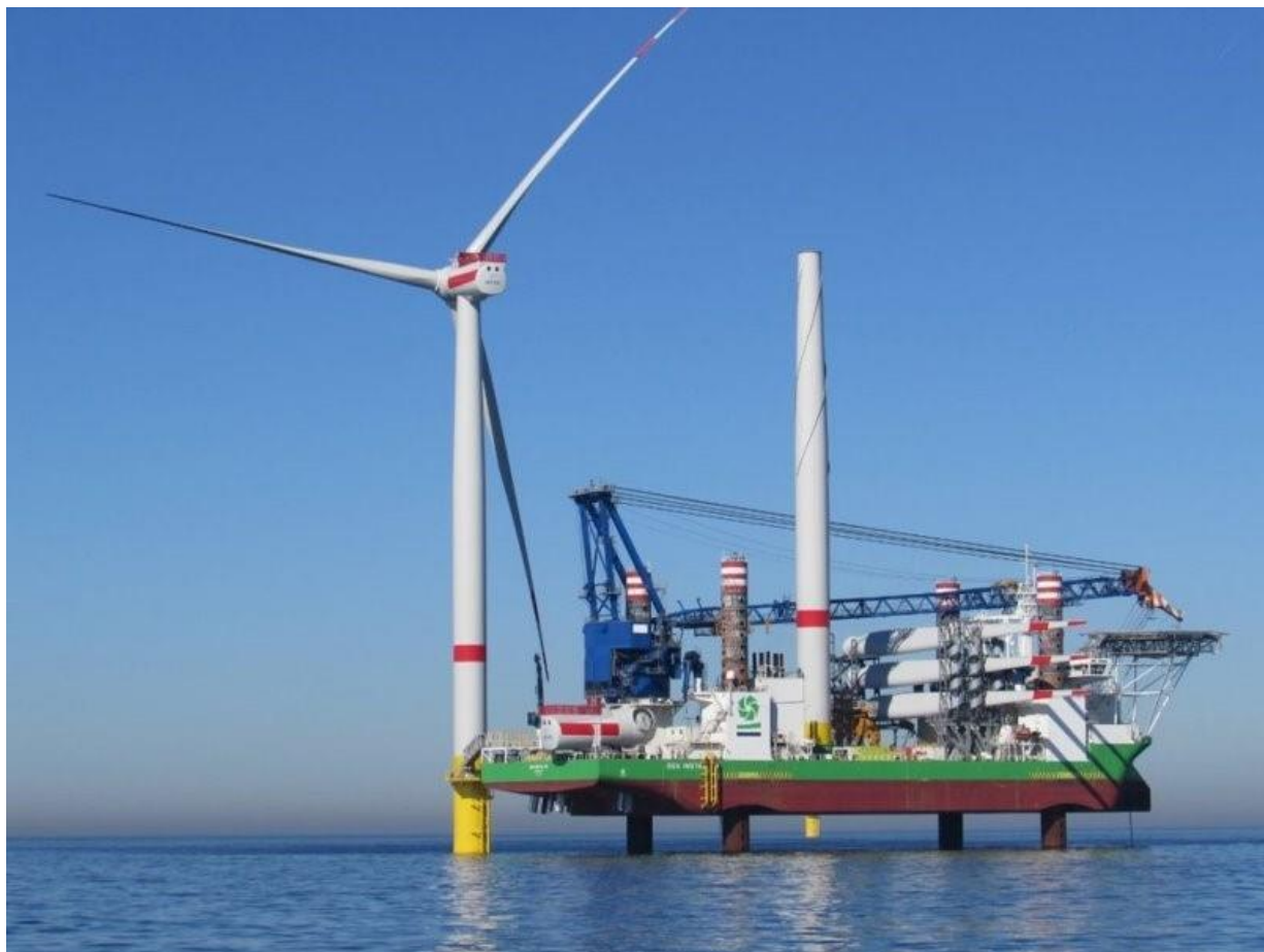
Figur 13. Montering av vindkraftverk med ett fartyg av typen jack-up. Källa: COWI
