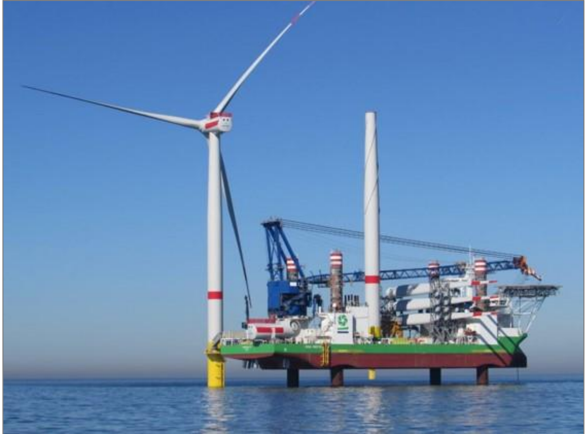
Figur1-11. Installation av ett havsbaserat vindkraftverk med ett jack-up-fartyg (bild: COWI).
