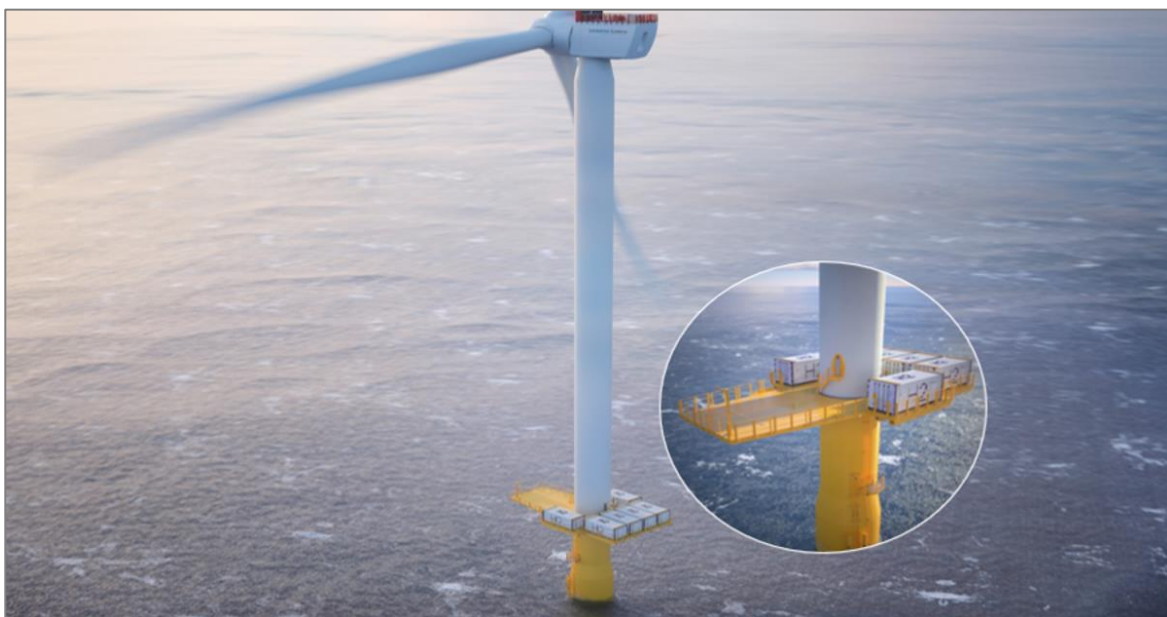
Figur2-6. Exempel på vätgasproduktion i nedre delen av tornet i ett havsbaserat vindkraftverk. Källa: Siemens-Gamesa.
