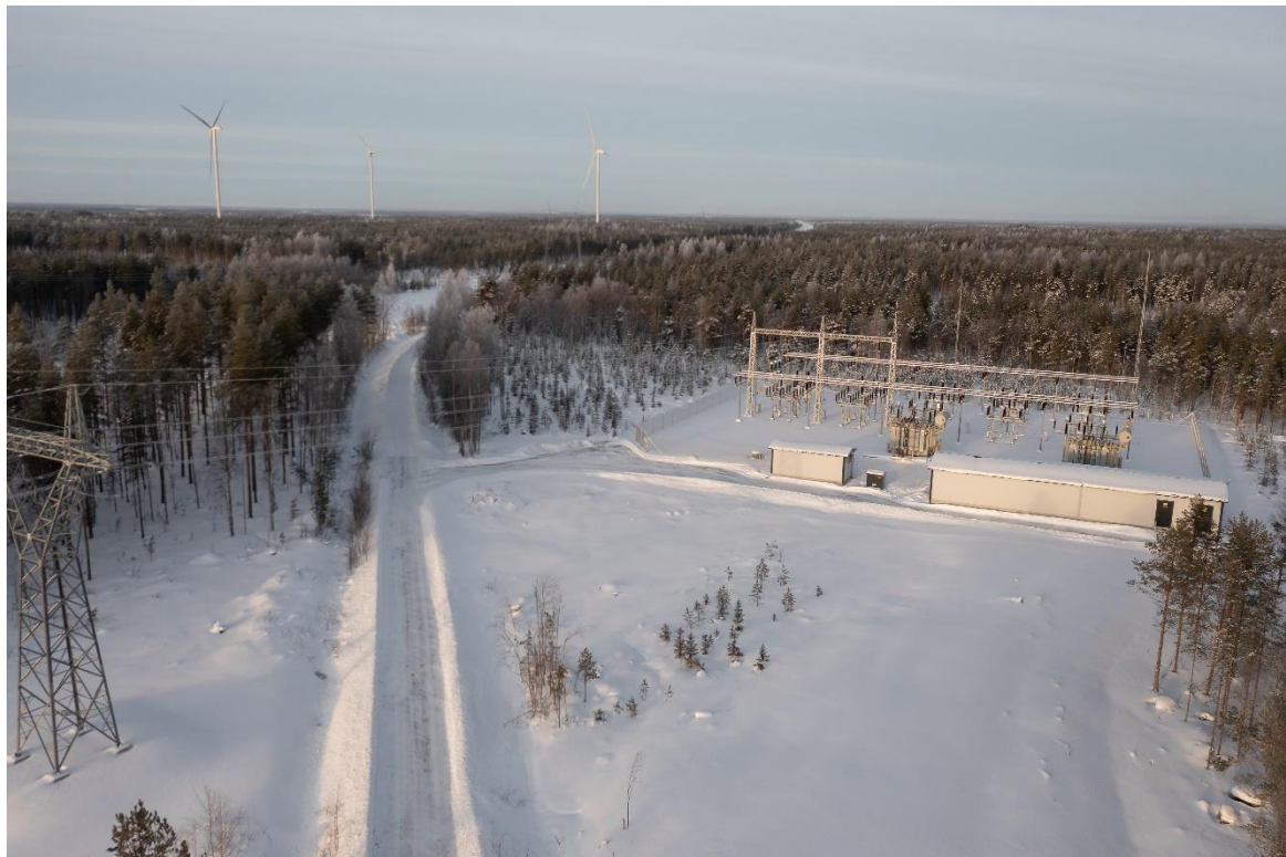
Figur 1-4. Exempel på elstation för vindkraftsprojekt (foto: Petteri Lövönen/OX2)
