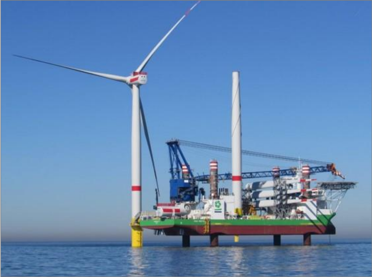
Kuva 3-11. Merituulivoimalan asennus jack-up aluksella (kuva: COWI).
