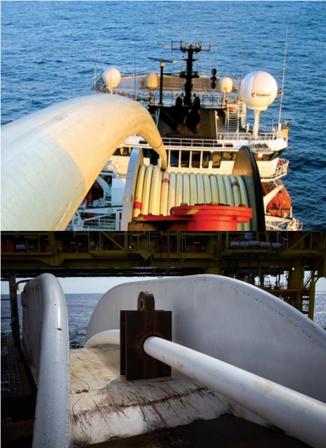
Kuva 4-4. Joustavan vetyputken asennus. Alemmassa kuvassa putken ympärille on lisätty painot. Lähde: SoluForce.
