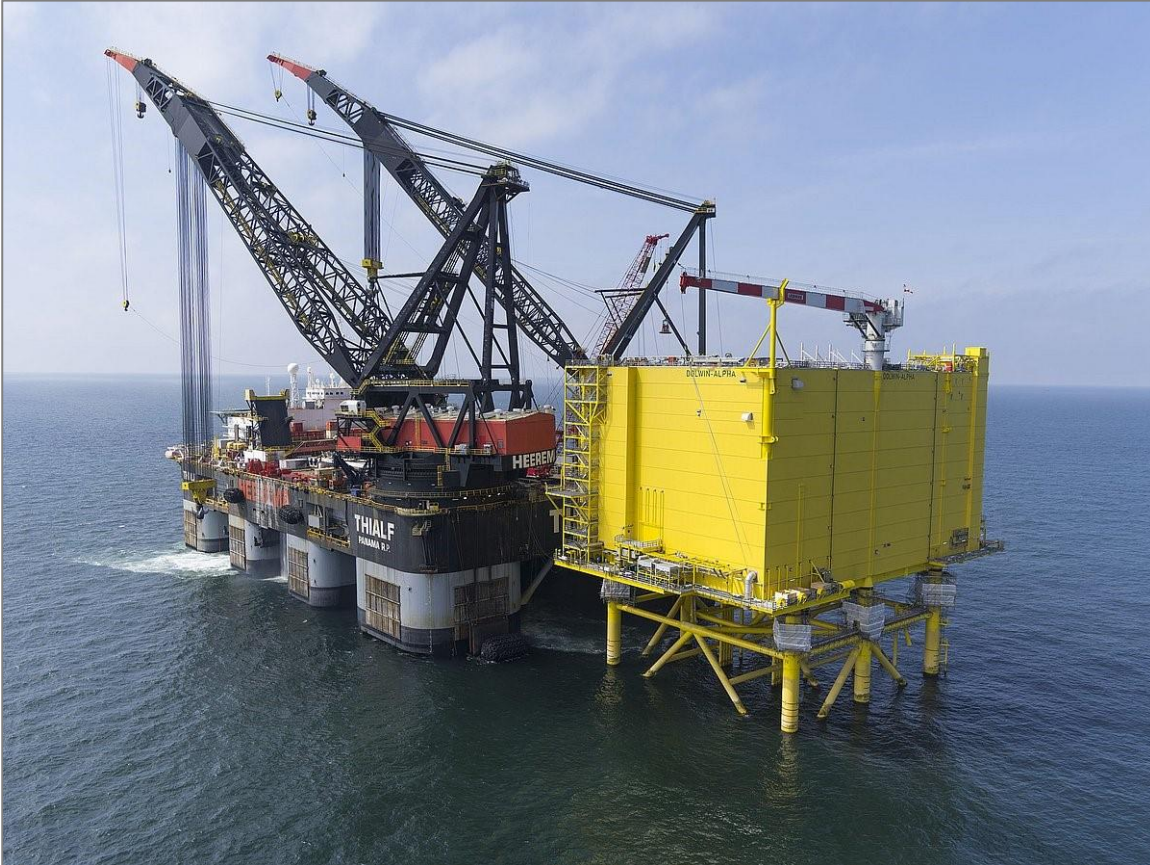
Kuva 4-7. HVDC DolWin Alpha, esimerkki asemasta, jossa on ristikkoperustus. Nosturialuksen nostokapasiteetti on noin 22 000 tonnia. Lähde: www.overdick-offshore.com .
