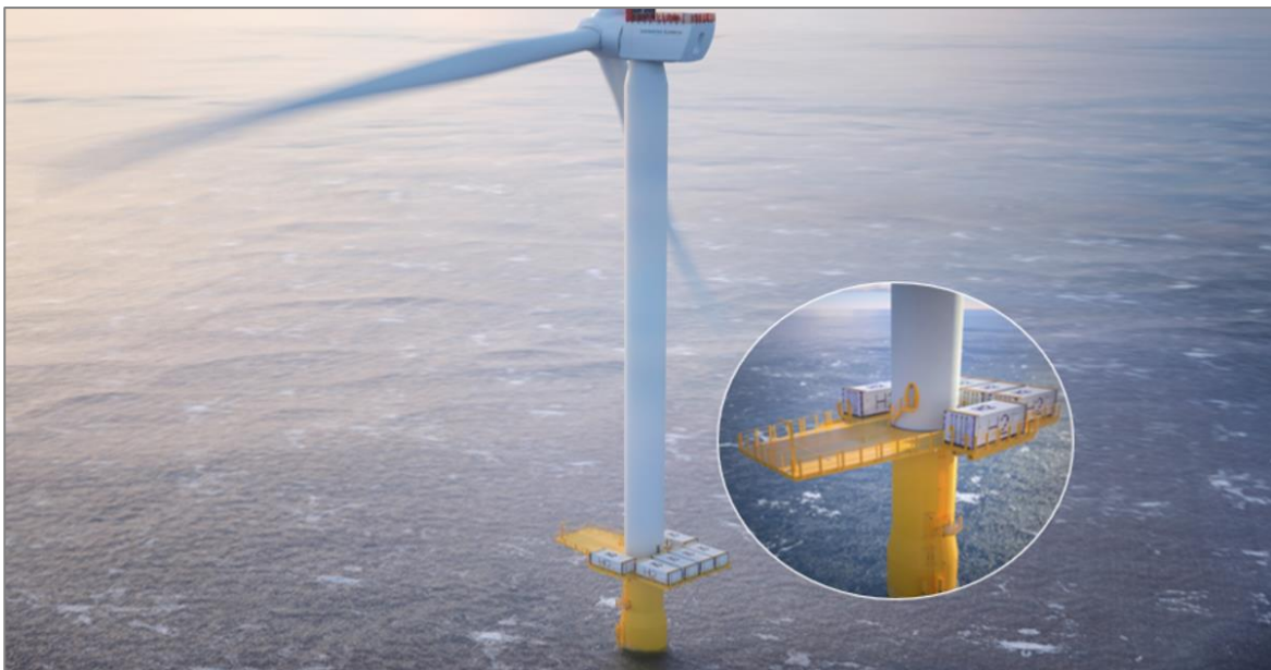
Kuva 4-6. Esimerkki vedyntuotannosta merituulivoimalan tornin alapäässä. Lähde: Siemens-Gamesa.
