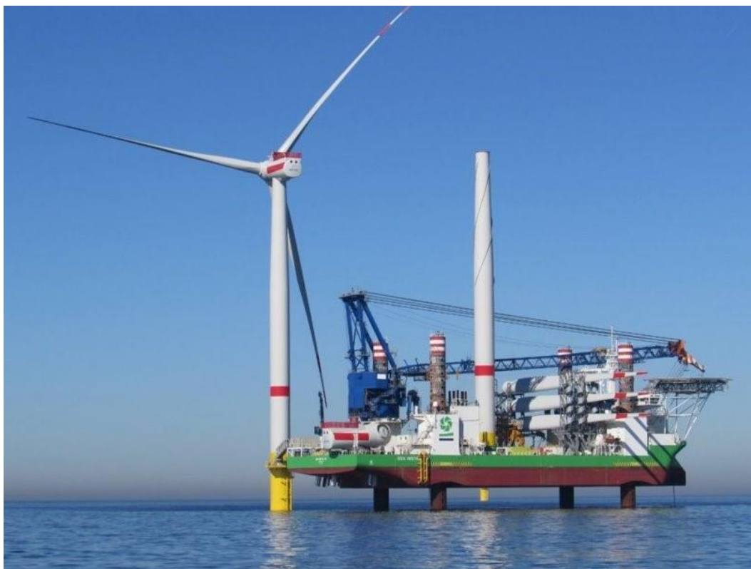
Figur 7. Montering av vindkraftverk med ett fartyg av typen stödbensplattform (jack-up). Källa: COWI
