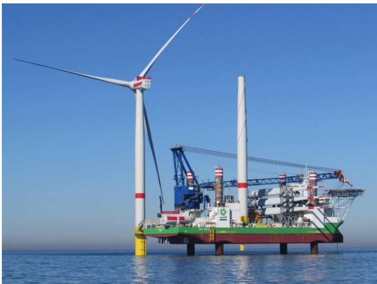
Figur 16. Montering av vindkraftverk med ett fartyg av typen jack-up. Källa: COWI
