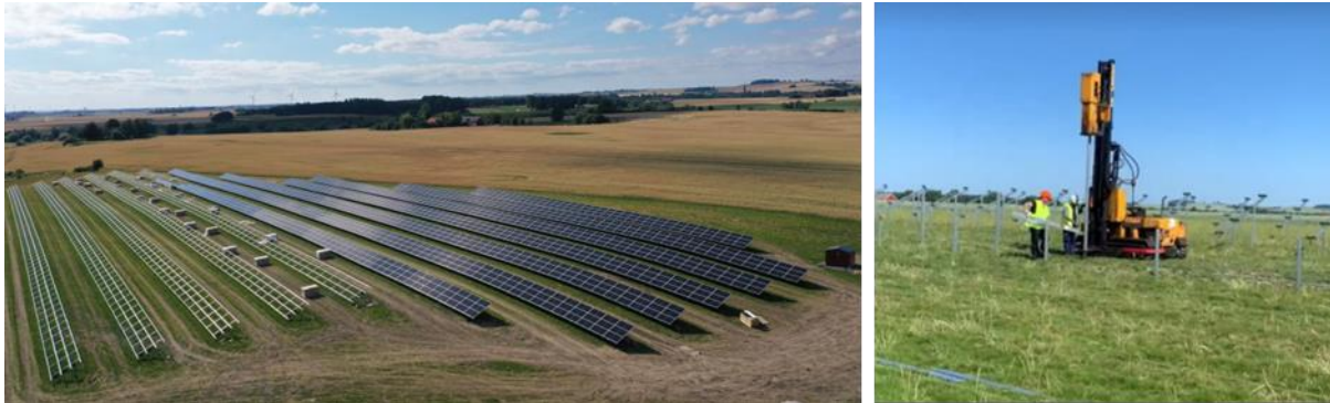
Figur 4.3. Vänster: exempel på montage av solpaneler på markställningar. Höger: Pålning av balkar med pålningsmaskin (foto: Magnus Fast, OX2).
