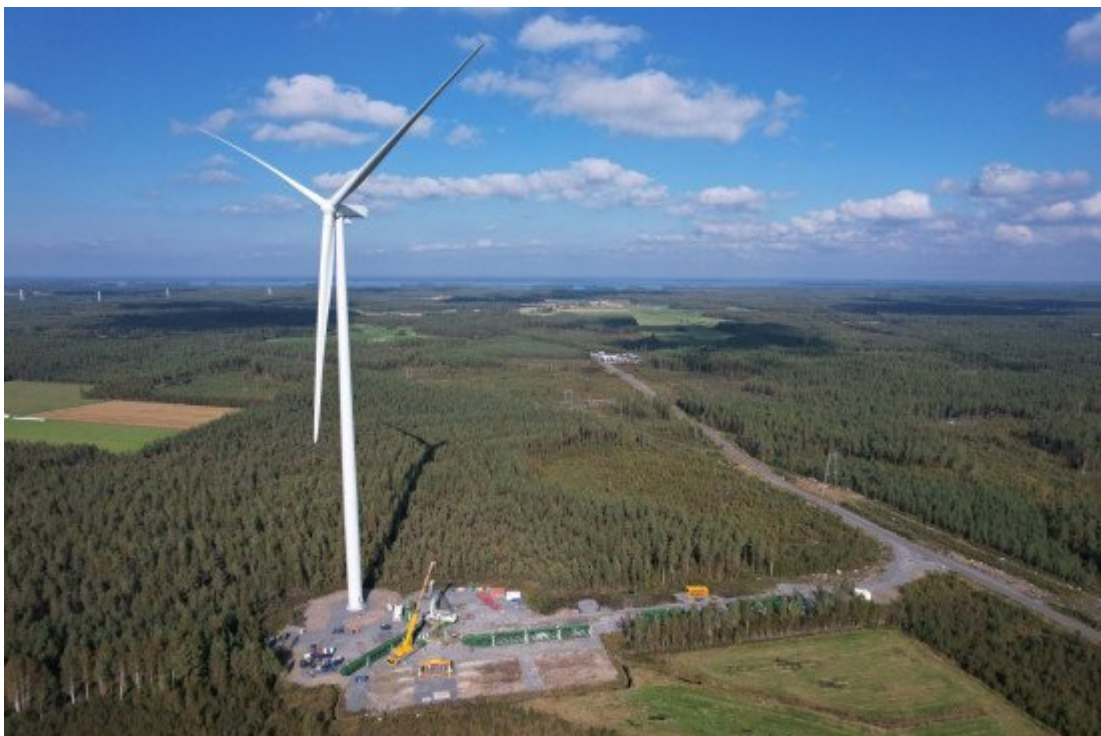
Tuulipuiston rakennustöitä Lestijärvellä. Kuva Jesse Lämpsä/AFRY
