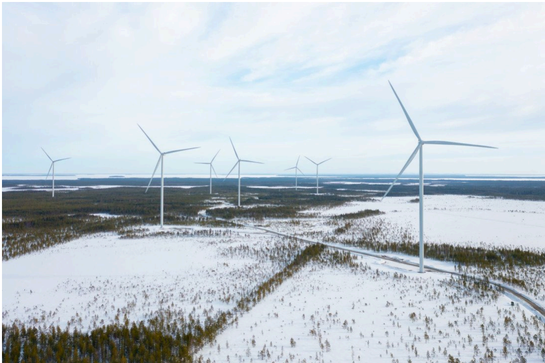
Kuva OX2:n toteuttamasta Metsäamminkankaan tuulipuistosta. Kuvaaja: Petteri Löppönen.
