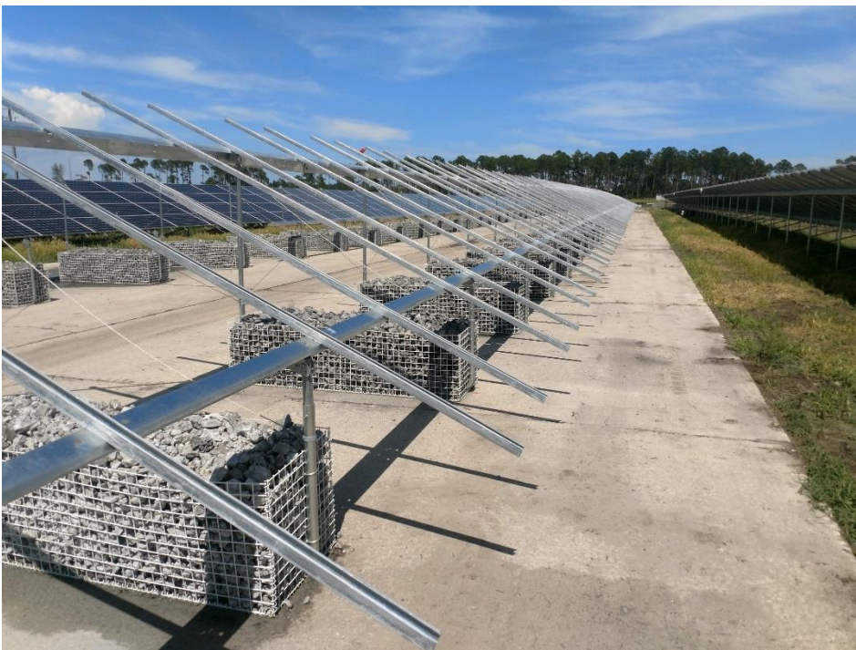
Figur 4.11. Exempel på gravitationsfundament (Källa: APA Solar Racking).
