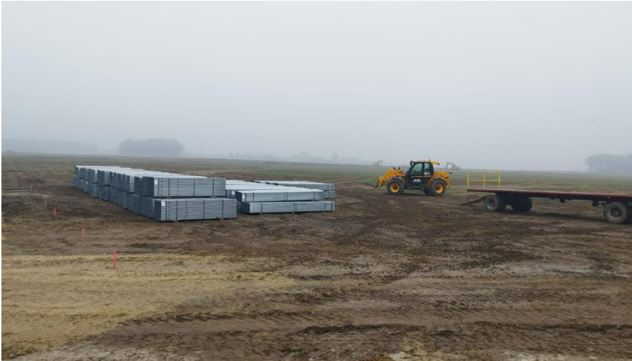
Figur 4.6. Exempel uppställningsyta inom solpark samt omlastning av material. Bilden tagen vid byggnation av OX2:s Rutki solpark i Polen.
