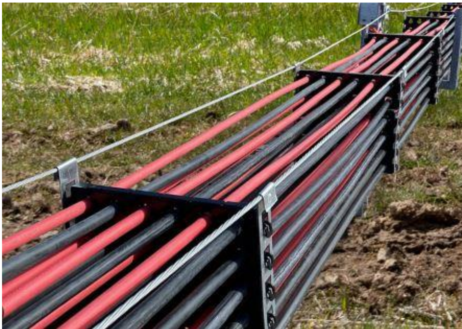
Figur 4.14. Kabelränna för kablar ovan mark (källa OX2)
