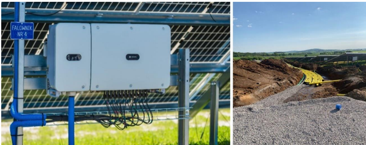
Figur 4.12. Vänster: växelriktare som monterats på markställning (bildkälla: www.ske-solar.com ). Höger: exempel på kabelschakt inom anläggningen (Foto: Magnus Fast, OX2).
