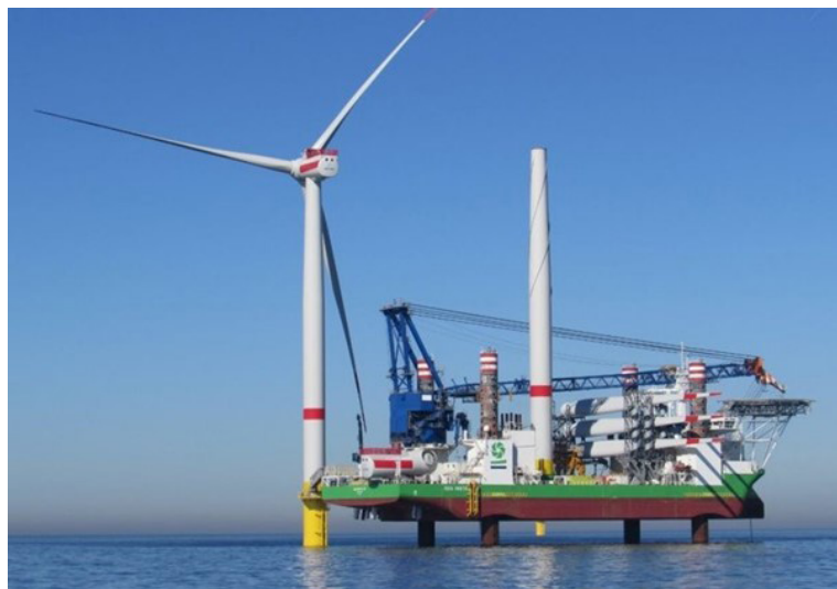
Figur 15. Montering av vindkraftverk med ett fartyg av typen jack-up. Källa: COWI
