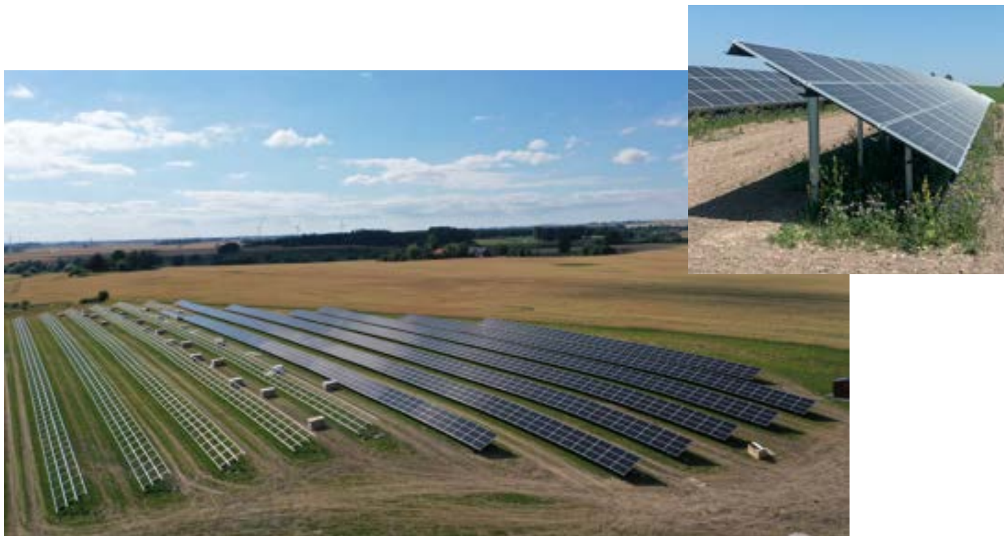
FIGUR 4 Exempel på solpaneler på markställningar. Den vänstra bilden visar pågående montering med markställningar utan solpaneler till vänster och markställningar med solpaneler till höger i bilden (Foto: Magnus Fast, OX2).
