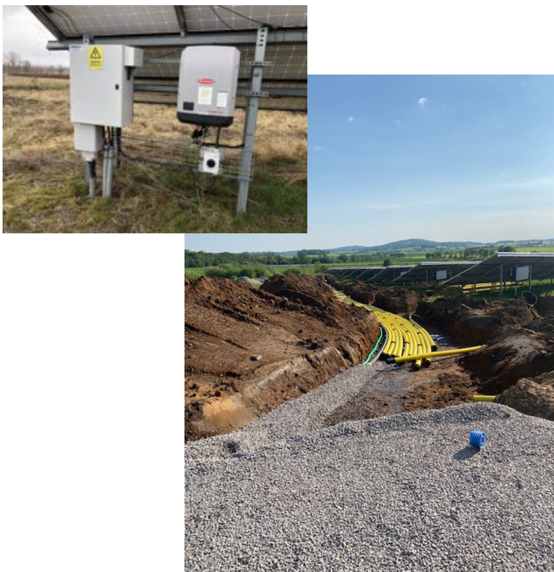
FIGUR 5 Till vänster, exempel på växelriktare som monterats på markställning (Foto: Eco-gain). Till höger, exempel på kabelschakt inom projektområdet (Foto: Magnus Fast, OX2).
