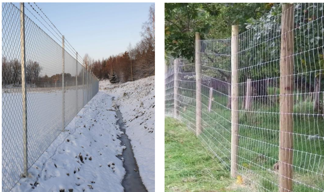
Figur 5-5. Exempel på industristängsel (vänster, bildkälla www.mmstangsel.se ) och viltstängsel (höger, bildkälla www.bole.se ).
