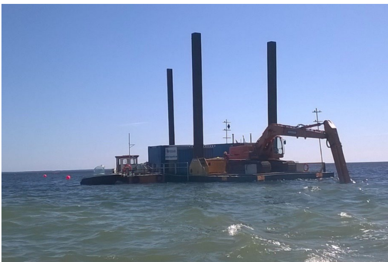
Figur 9. Grävmaskin på pråm, försedd med höj-och sänkbara ben.
