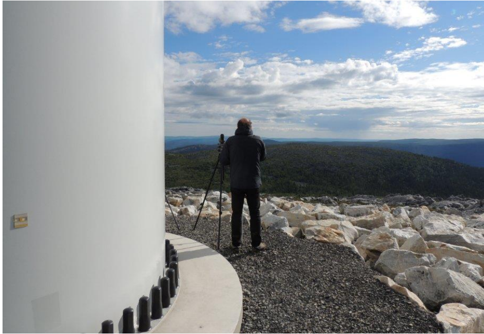
Bild 10 Janne spanar från ett av vindkraftverken på Glötesvålen.
