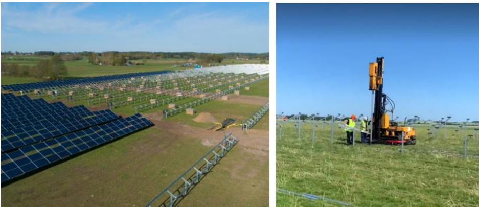
Figur 5-1. Vänster: exempel på montage av solpaneler på markställningar. Anläggningen är Svea Solars solenergianläggning i Sjöbo (Bildkälla: Ny Teknik). Höger: Pålning av balkar med pålningsmaskin (foto: Magnus Fast, OX2).
