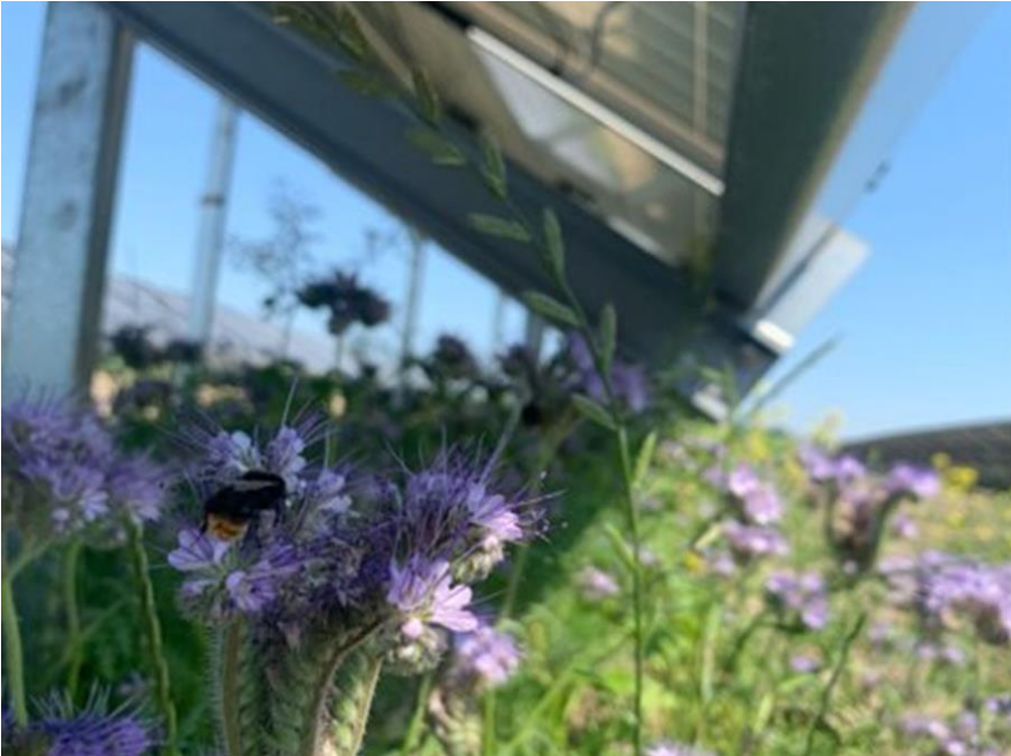
Figur 6-1. Blommande flora under solcellspaneler i drift. Foto: Magnus Fast, OX2.
