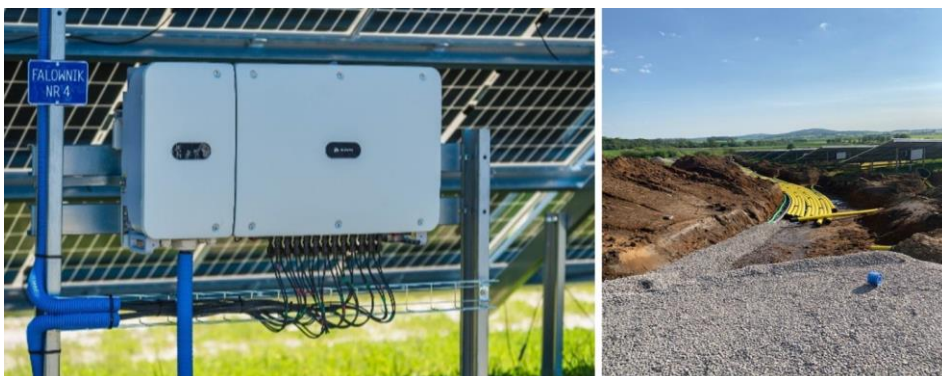
Figur 5-2. Vänster: växelriktare som monterats på markställning (bildkälla: www.ske-solar.com). Höger: exempel på kabelschakt inom anläggningen (foto: Magnus Fast, OX2).
