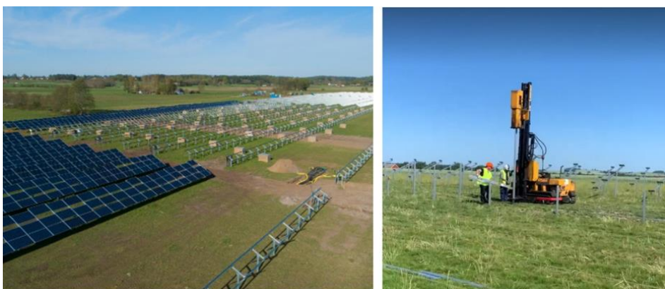
Figur 8. Vänster: exempel på montage av solpaneler på markställningar. Anläggningen är Svea Solars solenergianläggning i Sjöbo (Bildkälla: Ny Teknik). Höger: Pålning av balkar med pålningsmaskin (foto: Magnus Fast, OX2).
