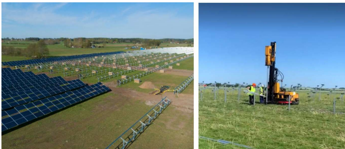
Figur 14. Vänster: exempel på montage av solpaneler på markställningar. Anläggningen är av en solcellspark i Sjöbo (Bildkälla: Ny Teknik). Höger: Pålning av balkar med pålningsmaskin (foto: Magnus Fast, OX2).
