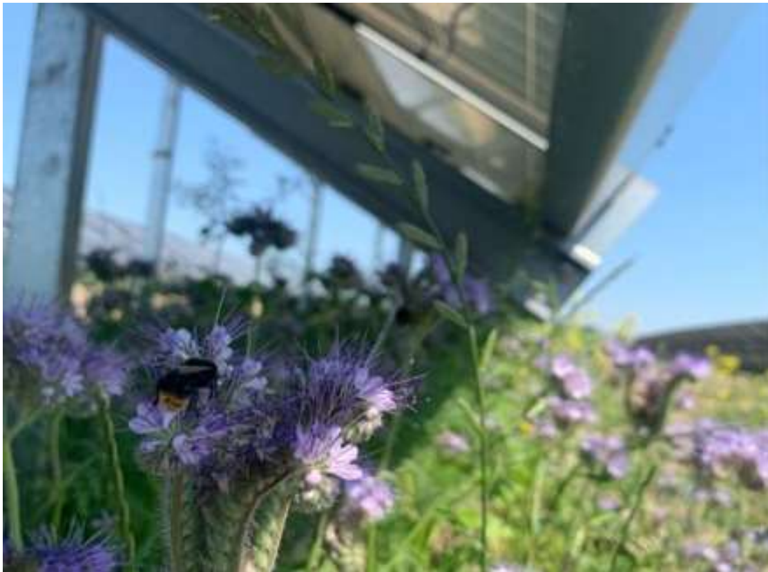
Figur 17. Blommande flora under solcellspaneler i drift. Foto Magnus Fast, OX2.
