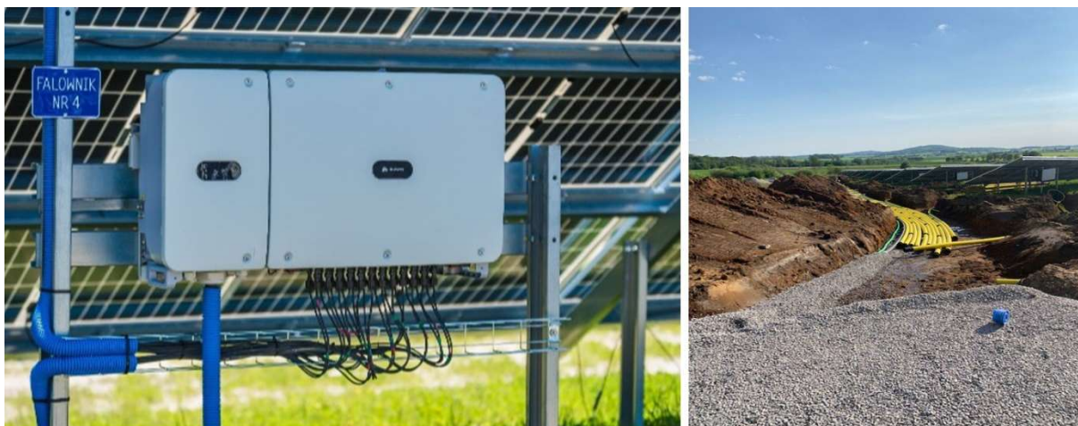
Figur 15. Vänster: växelriktare som monterats på markställning (bildkälla: www.ske-solar.com). Höger: exempel på kabelschakt inom anläggningen (foto: Magnus Fast, OX2).
