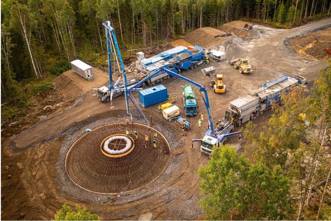
Figur 8. Montageyta från byggnation av Klevberget vindpark. Foto: OX2
