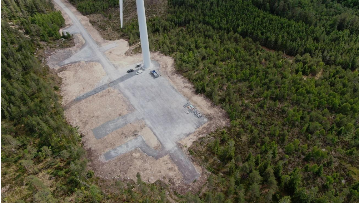
Figur 9. Montageyta vid vindkraftverk i drift i Vindpark Karskruv. Foto: OX2
