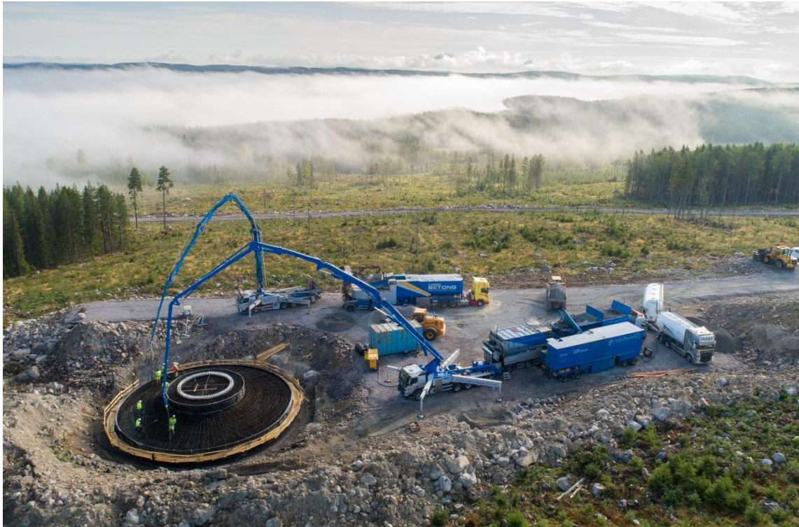
Figur 20. Gjutning av bergsfundament i Åmot-Lingbo vindpark, Sverige. Två mobila betongstationer blandar betong direkt på montageytan. Foto: OX2
