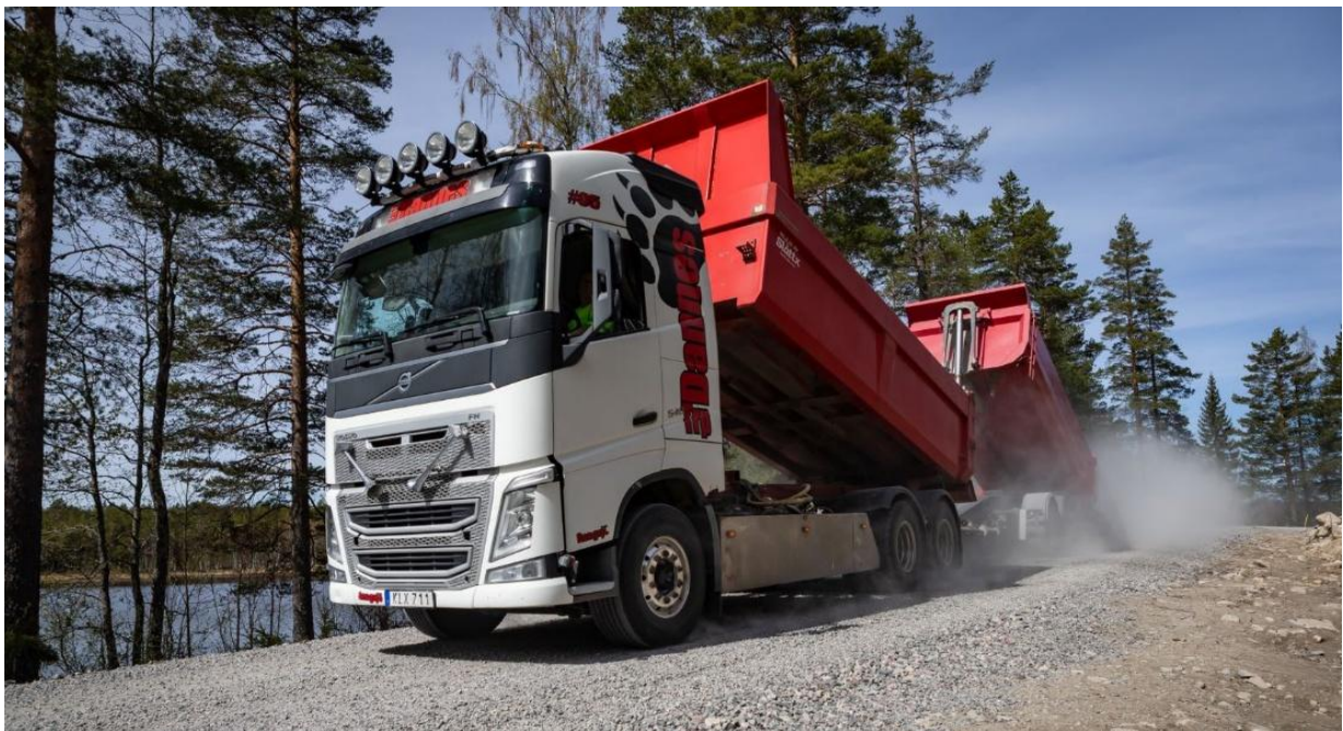
Figur 14. Förstärkning av vägsträcka intill Mosjön, vid byggnation av Vindpark Valhalla. Foto: OX2
