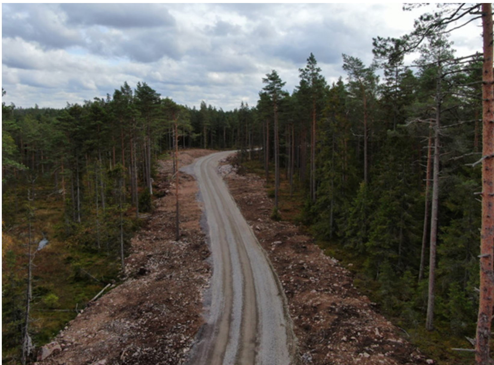
Exempel på nyanläggning av väg inom Karskruv vindpark.
