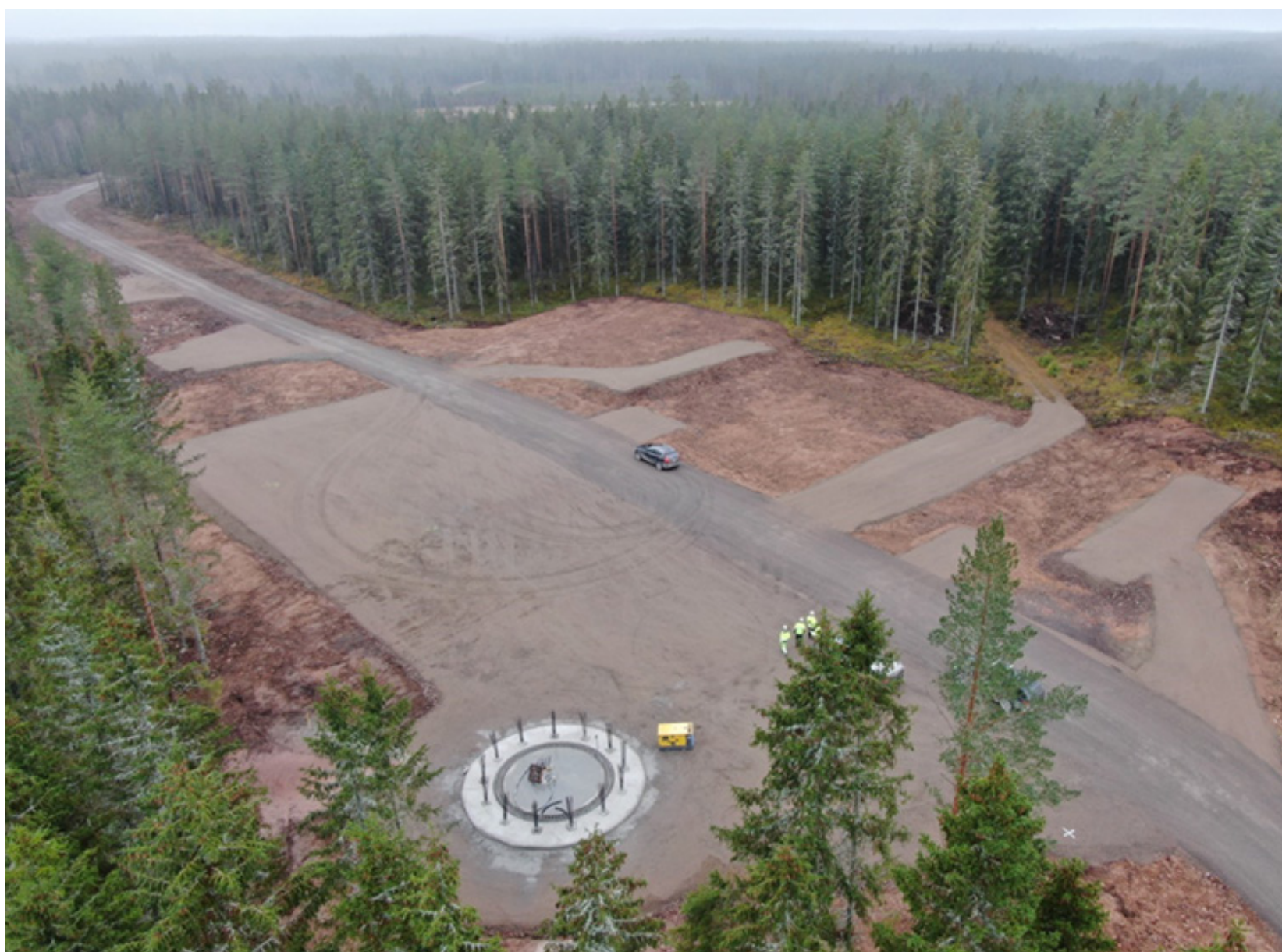
Turbinposition redo för leverans och montage av vindkraftverk.
