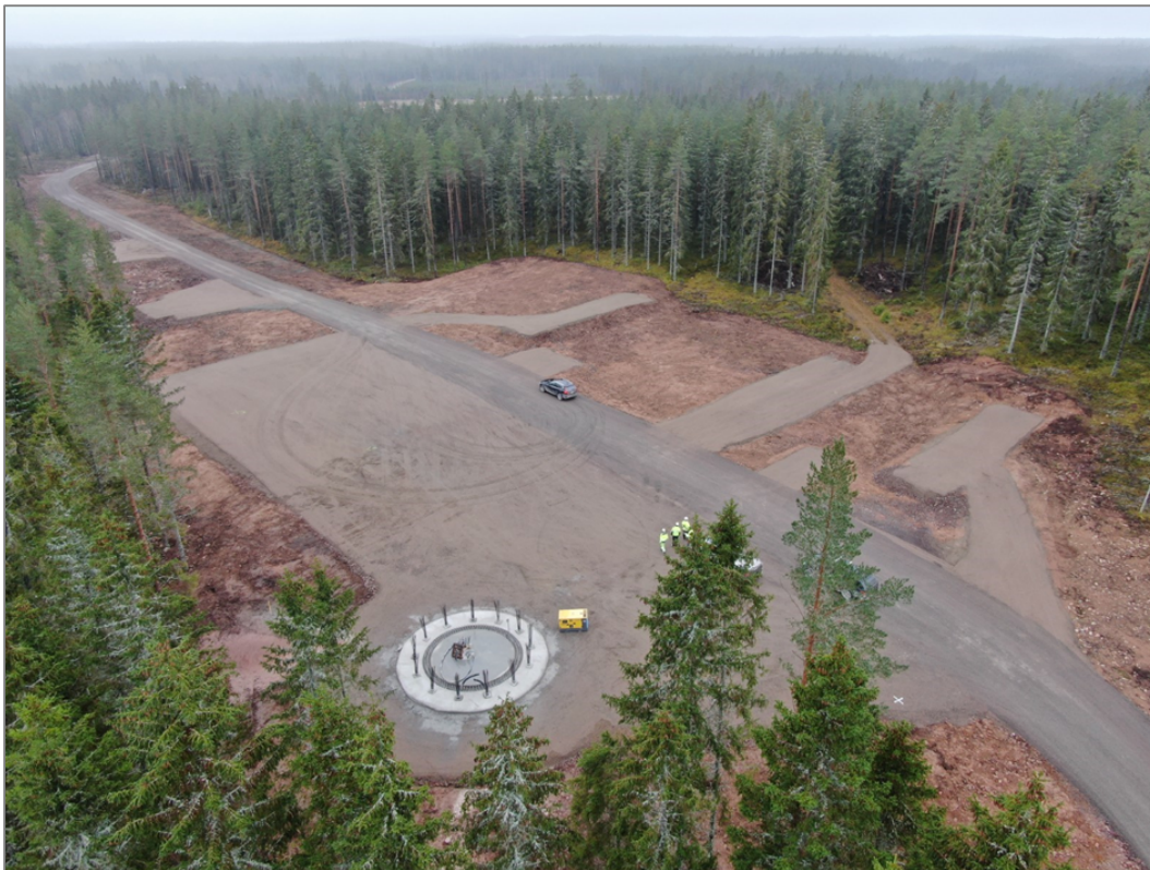
Figur 5. Exempelfoto från en turbinposition som är redo för leverans och montage av vindkraftverk. Foto: OX2.
