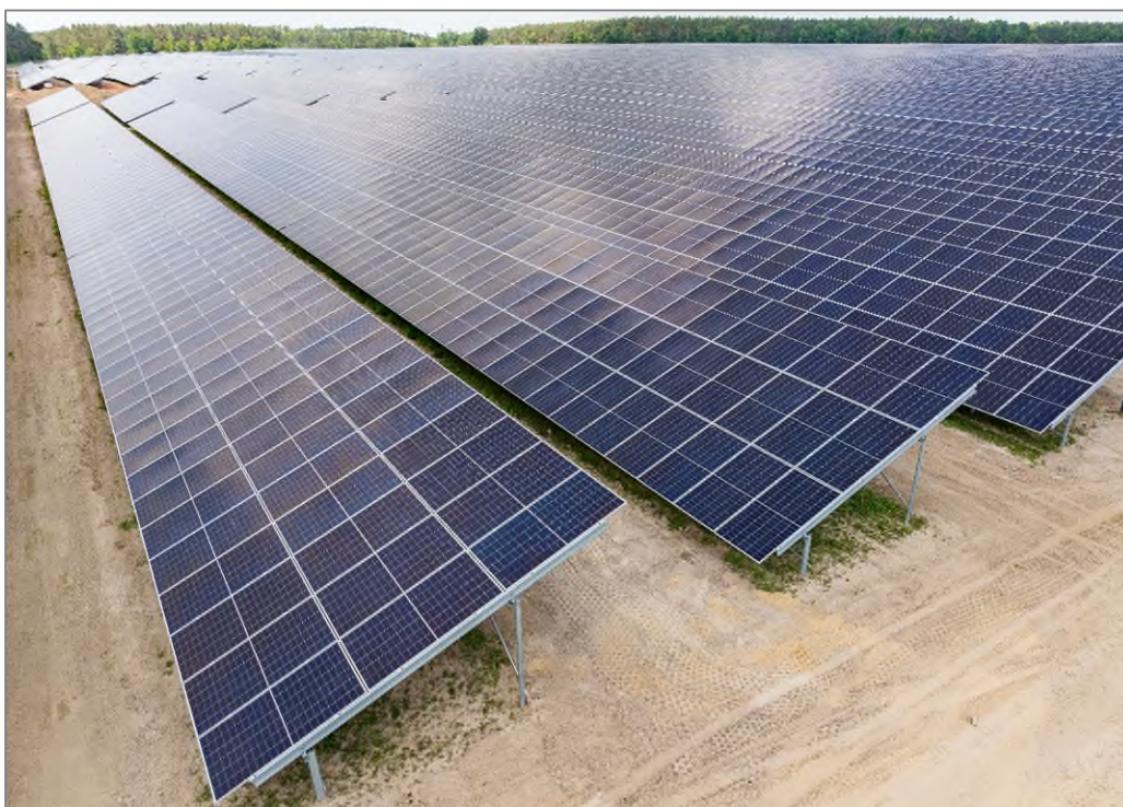
Figur 4. Exempel på montage av solpaneler på markställningar. Foto: OX2 AB.
