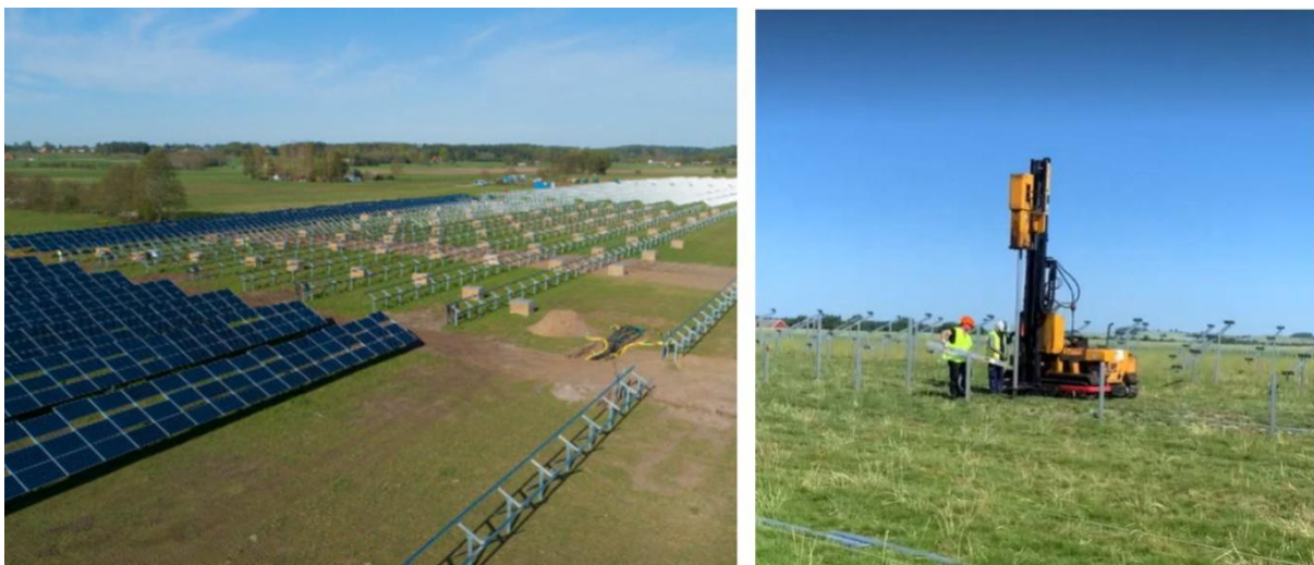
Figur 13. Vänster; exempel på montage av solpaneler på markställningar. Anläggningen är Svea Solars solpark i Sjöbo (bildkälla: Ny teknik). Höger: pålning av balkar med pålningsmaskin (foto: Magnus Fast, OX2).
