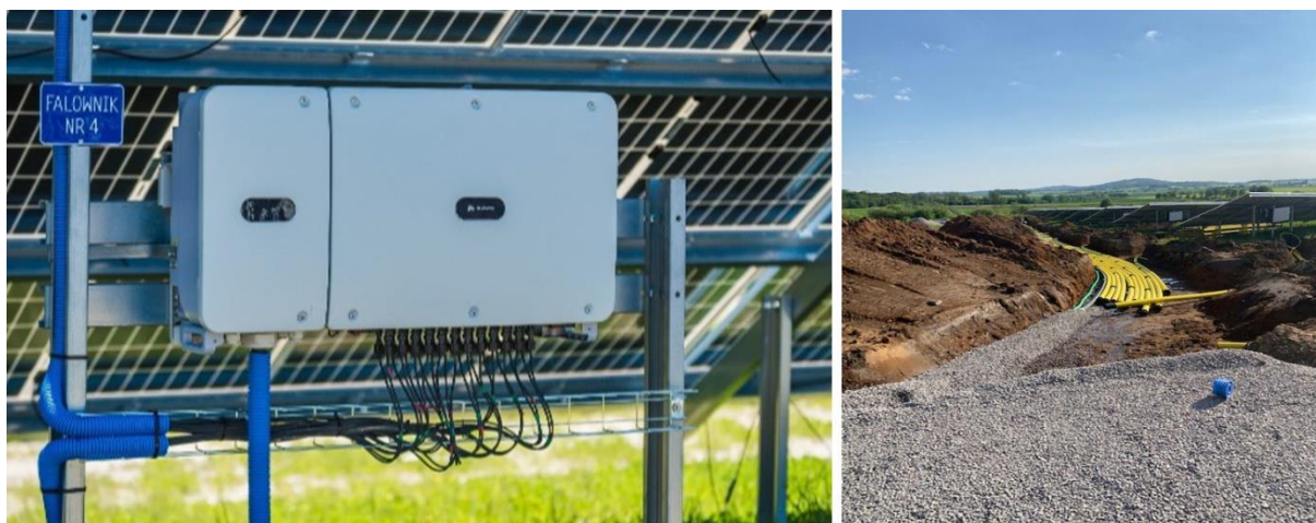
Figur 9. Vänster: växelriktare som monterats på markställning (bildkälla: www.ske-solar.com). Höger: exempel på kabelschakt inom anläggningen (foto: Magnus Fast, OX2).
