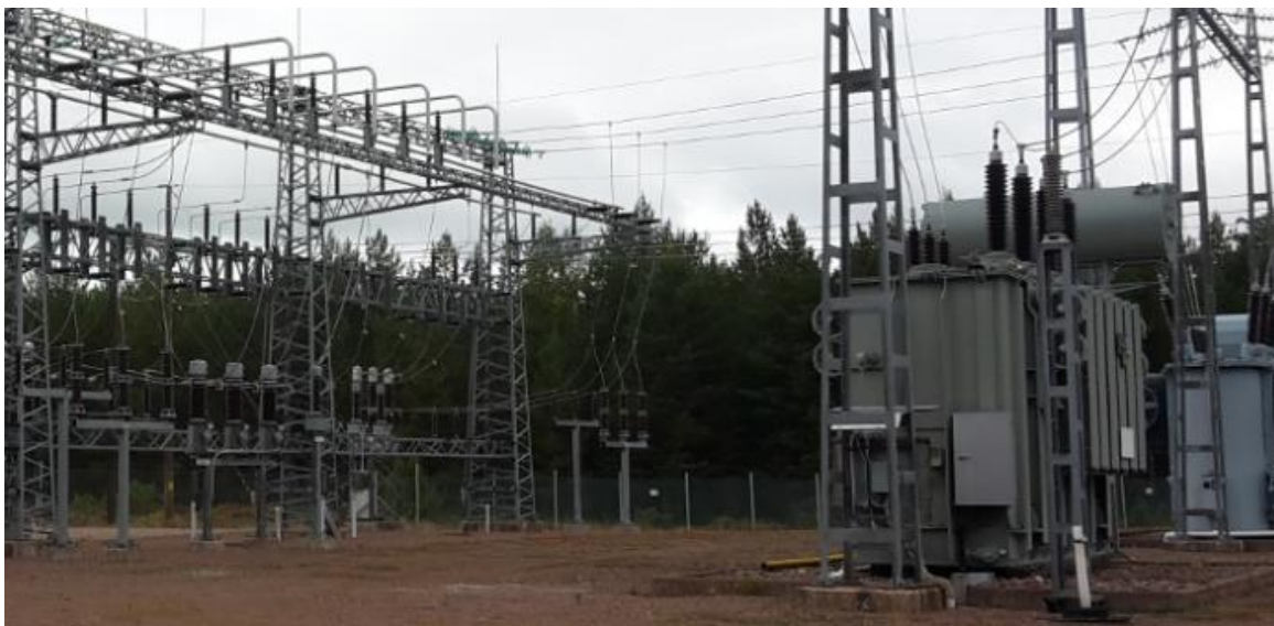
Figur 11. Exempel på ställtverk för anslutning av solenergianläggningen till elnätet. Bildkälla: www.vattenfall.com
