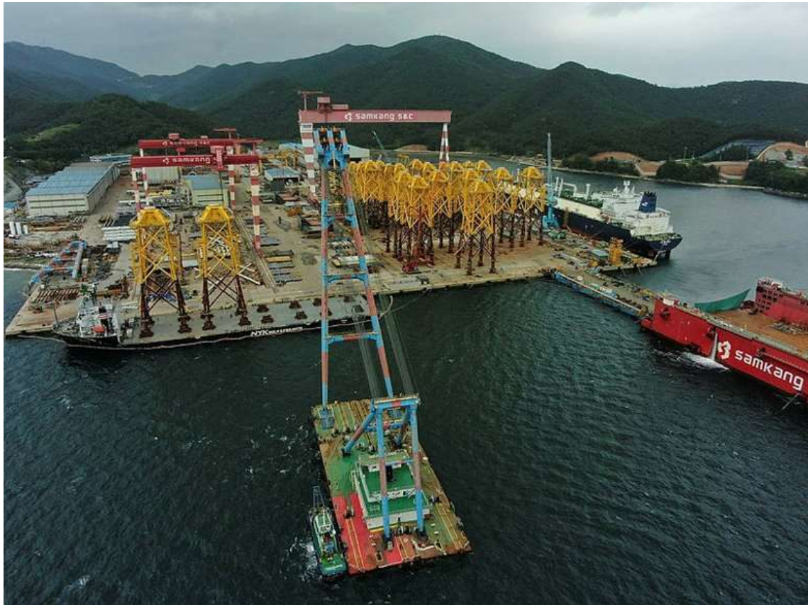
Figur 15. Fackverksfundament vid kaj (Källa COWI).
