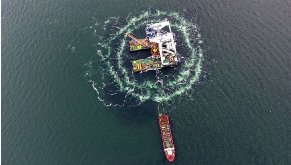
Figur 32. Anläggningsarbete med dubbla bubbelgardiner (Källa: Hydrotechnik Lübeck).
