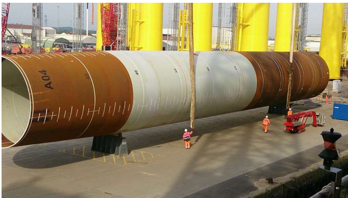
Figur 12. Tillverkning av fundament. I bakgrunden syns färdiga övergångsstycken (Källa COWI).
