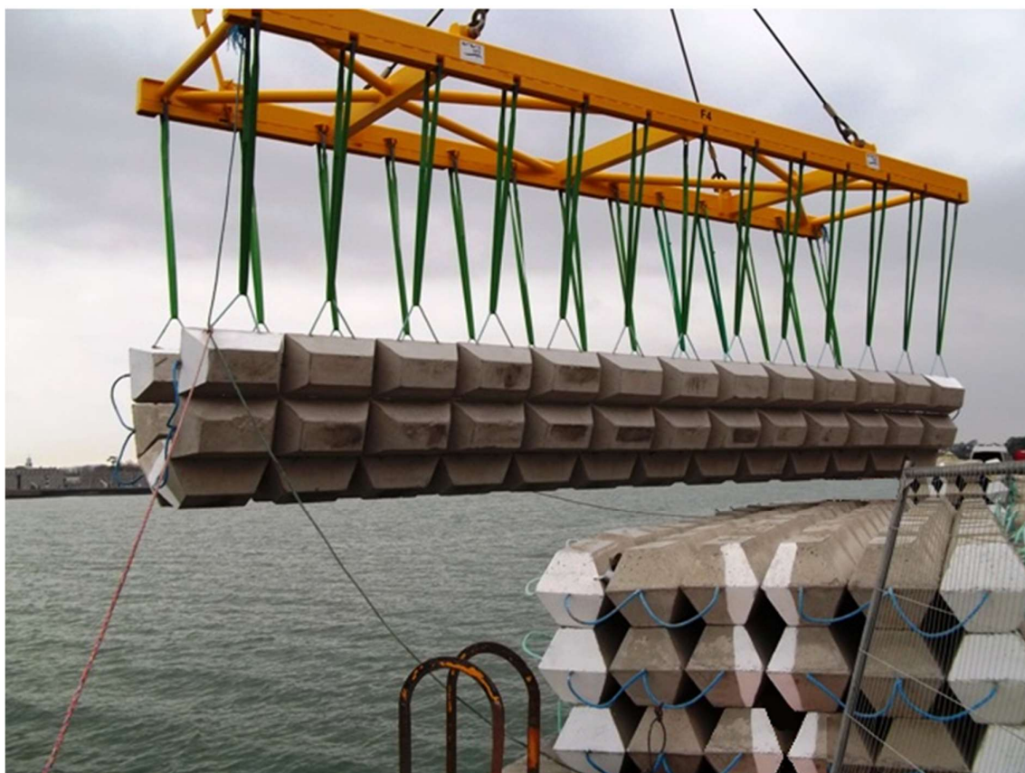
Figur 25. Exempel på betongmadrass som används som kabelskydd (Källa: Subsea Protection Systems).
