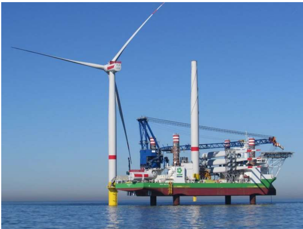
Figur 8. Montering av vindkraftverk med ett fartyg av typen jack-up. Källa: COWI
